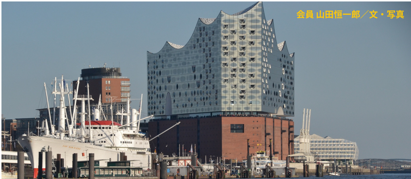
煉瓦倉庫の上に波をイメージしたガラス構造建築のエルプ・フィルハーモニー。コンサート・ホールのインテリアは音響設計家豊田泰久氏設計。
